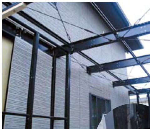
住宅の増築時の梁の接合
