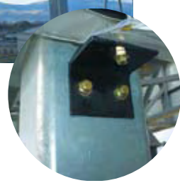
角形鋼管への テントユニットの取付け
